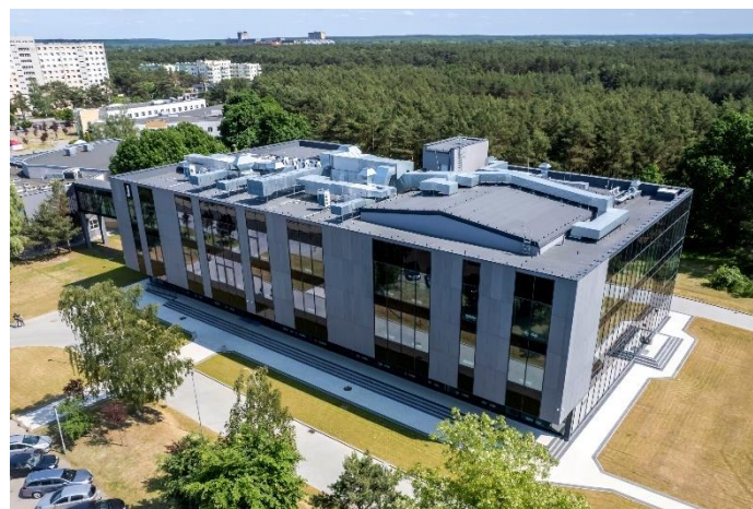
WIDOK BUDYNKU „J”
